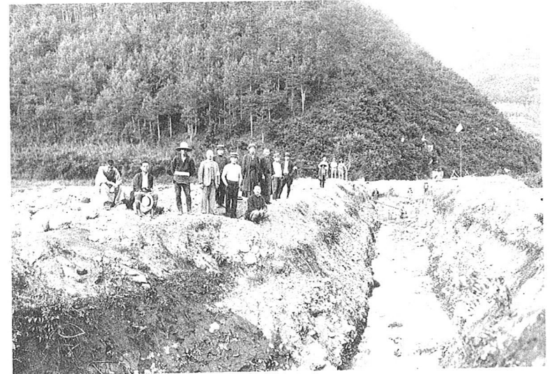
旧禾生簡易水道集水管布設工事 (昭和12年)
