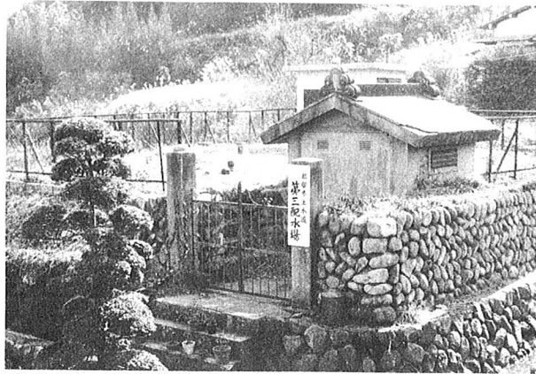
第三配水場 容量 150 m
