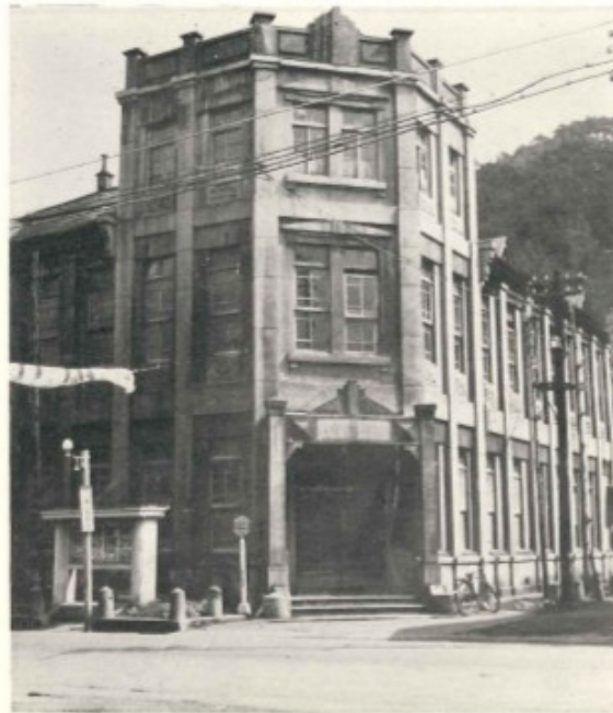
市 役 所 庁 舎 全 景
