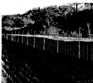
電気柵設置状況
