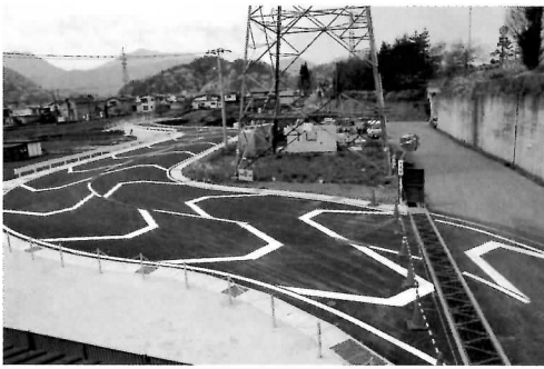
工事が進む市道栄町四日市場線の状況
