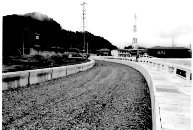
建設工事が進むインターチェンジ周辺道路
