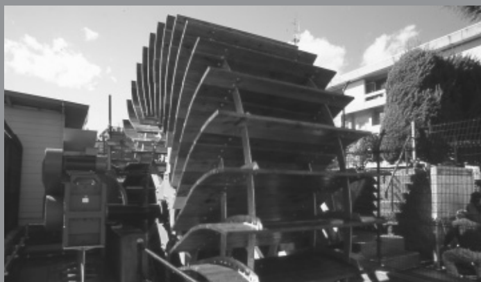
市役所駐車場に発電所
