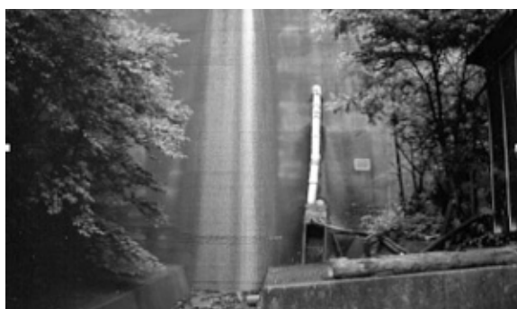
鉦山下部にある砂防ダム
