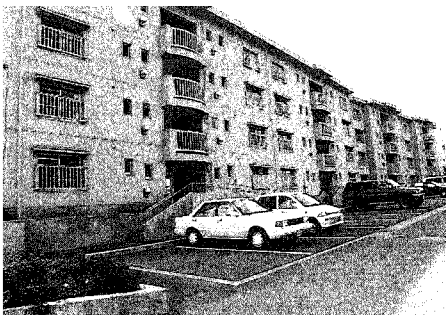
公営住宅の建設
