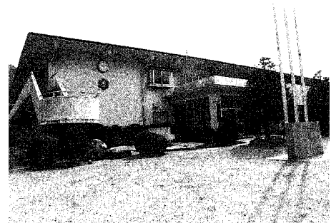
小中学校の耐震補強工事
