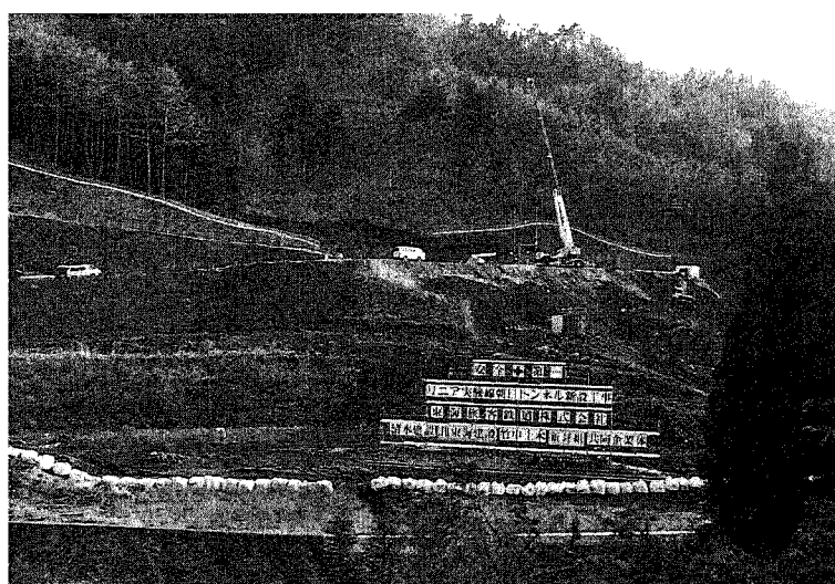
▲ 山梨リニアモーターカー実験線建設工事(大平地内)
