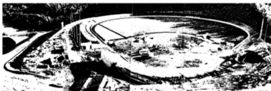
建設中の総合運動公園野球場 (59・10・21撮影)
